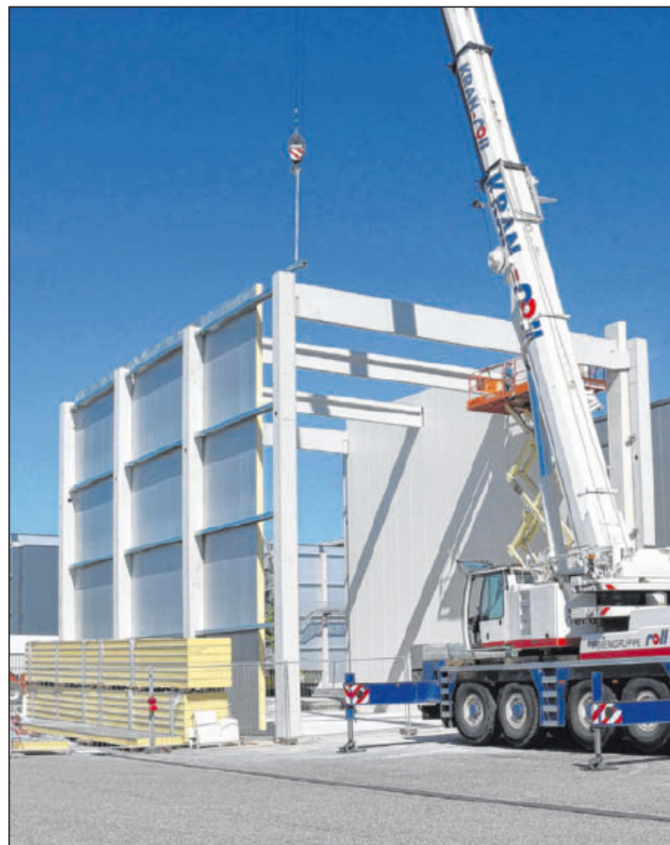
Vor 14 Tagen wurde mit dem Bau der neuen Halle auf dem Werksgelände begonnen. Bis in drei Monaten soll die Anlage betriebsbereit sein. Foto: Katharine Pajonk
