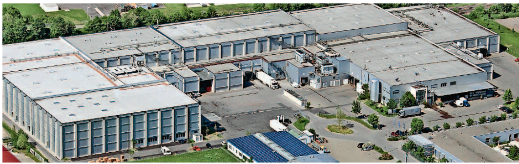
CDS Hackner: Firmengelände
